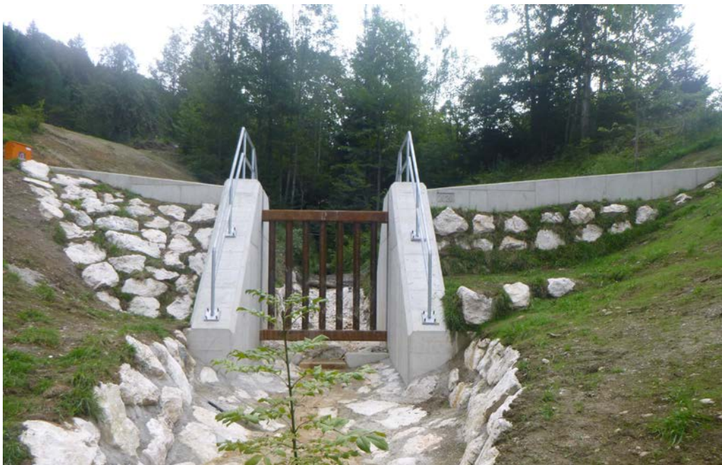
Abb. 1: Geschiebe- und Wildholzurückhaltesperre am Lettengraben
