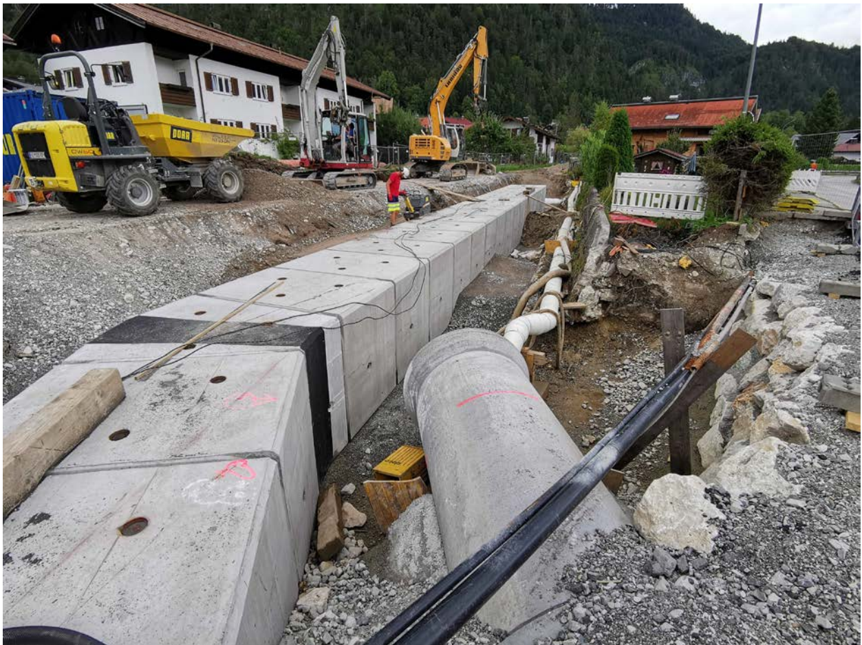
Abb. 2: Gerinneausbau Hausbach: mit großem Gerät werden die bis zu 6 Tonnen schweren Fertigteile des Hochwasserentlastungskanals eingehoben
